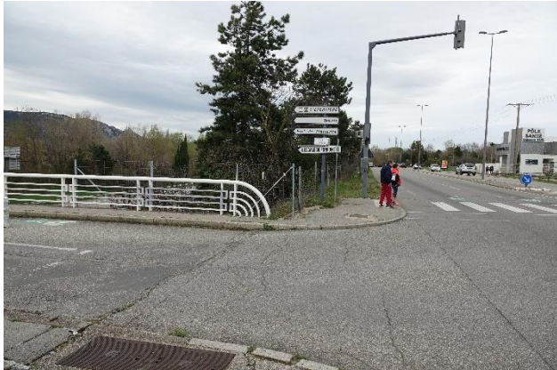
Avant travaux ©photo REVV
