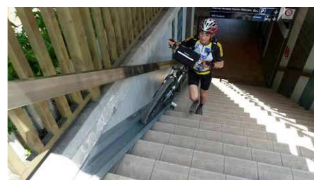
Goulotte en gare de Grenoble
