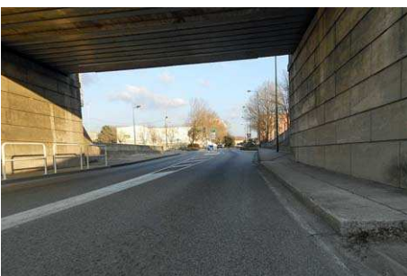
Av. J.F.Kennedy sous la voie ferrée
