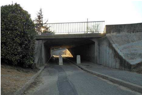
Passage piétons et vélos sous la RN 7
